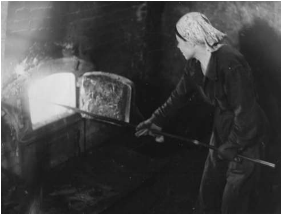
Котельная – обеспечивала производственные цеха паром.
